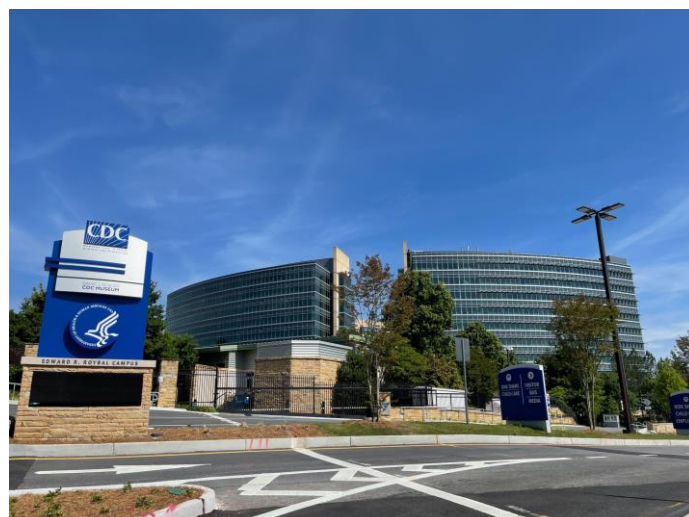
図2: CDC メインゲートからの外観
